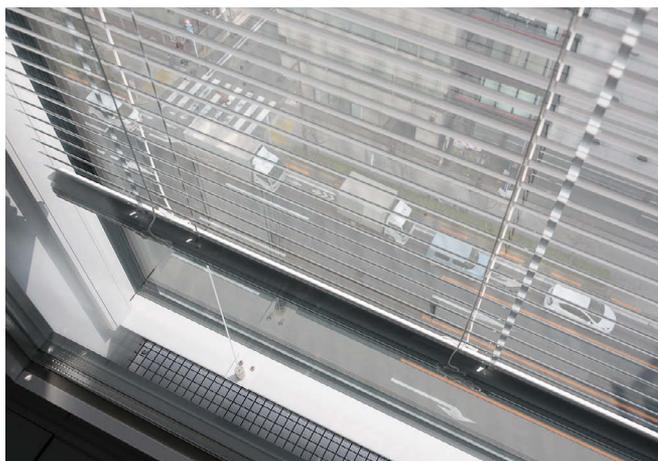
ダブルスキン構造特有の空気の対流によるブラインドの揺れを軽減するようにガイドワイヤー仕様を採用しています。
