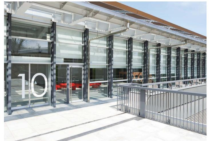
スクリーン裏面に施されたアルミ蒸着が強い日射熱を遮断するとともに、外からの視線もカットします。
