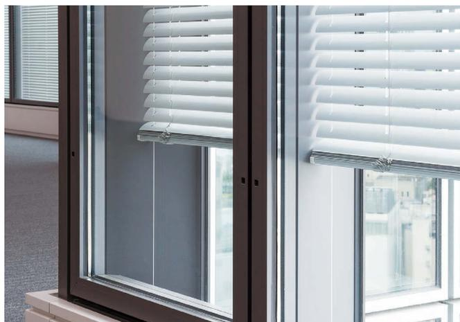
ダブルスキン構造特有の空気の対流によるブラインドの揺れを抑えるため、ガイドワイヤー仕様を採用しています。
