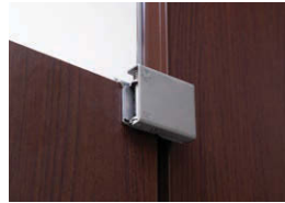
ブース内側から見た 非常解戸当り固定の状態
